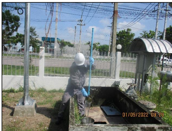
รูปที่ 3-8 การเก็บตัวอย่างคุณภาพน้ำทิ้ง
