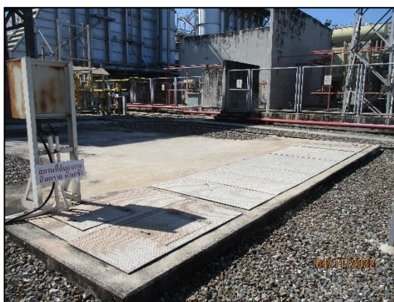
รูปที่ 2-8 ระบบ Oil Separator
