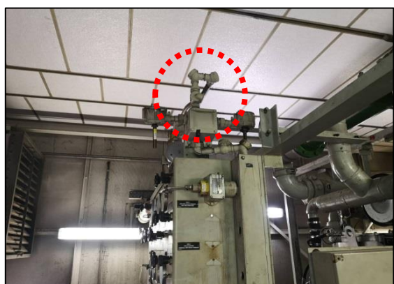
รูปที่ 2-17 อุปกรณ์ตรวจจับก๊าซรั่วไหล
