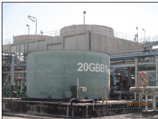
รูปที่ 2-9 บ่อรวบรวมน้ำทิ้งจากกระบวนการผลิต
